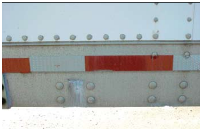
Ovan: Aluminum trailer före behandling med VpCI®-427 och VpCI®-426
