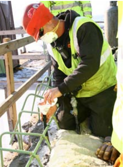
Steg 3: MCI®-molekyler fortsätter att migrera genom kapillärverkan, ångfasverkan och jonverkan och bildar ett tätt MCI®-skikt på ytan.
